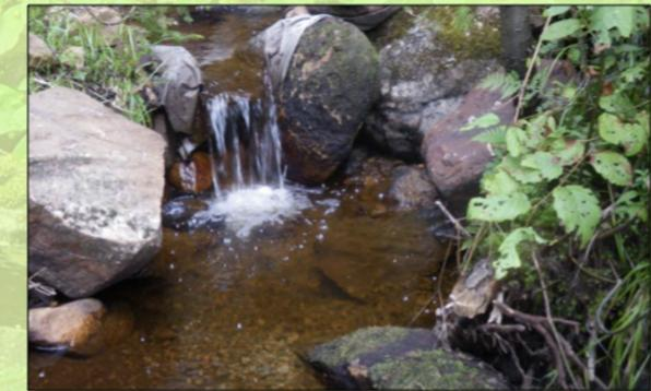
Exemple d'un aménagement de seuil en enrochement. Travaux effectués en 2010 au lac Marida par le biologiste Maxime Robillard.
